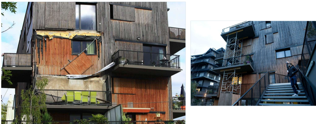
FIGURE 19 – Ginko - Effondrement d'un balcon et treize autres jugés défectueux (Béziat B., 2016)
