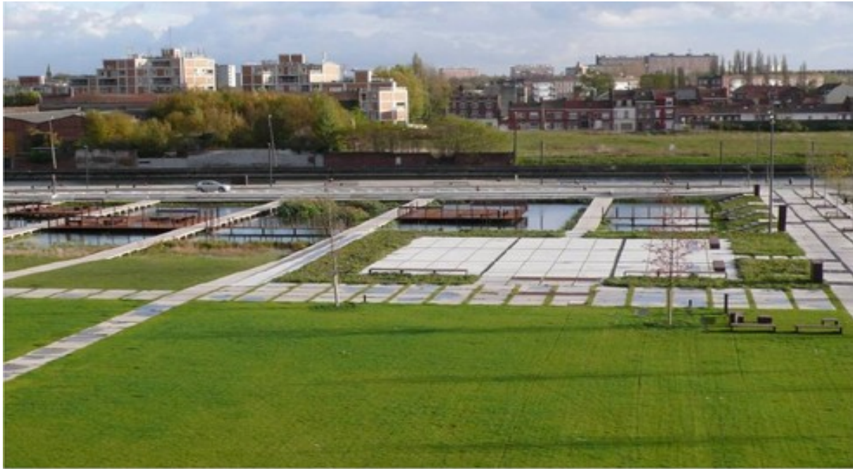
Figure 14. Bassin d'orage et de dépollution ( Source: Atelier de paysages Bruel Delmar )
