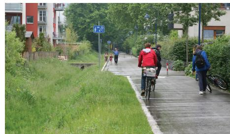
Figure 64: Exemple de noue le long d'un cheminement
