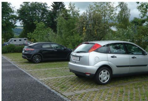
Figure 60: Exemple de stationnement en grilles gazon
